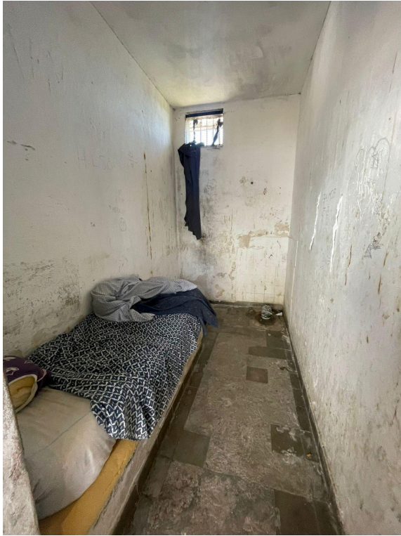
Celdas Especiales Individuales (Aislamiento):
